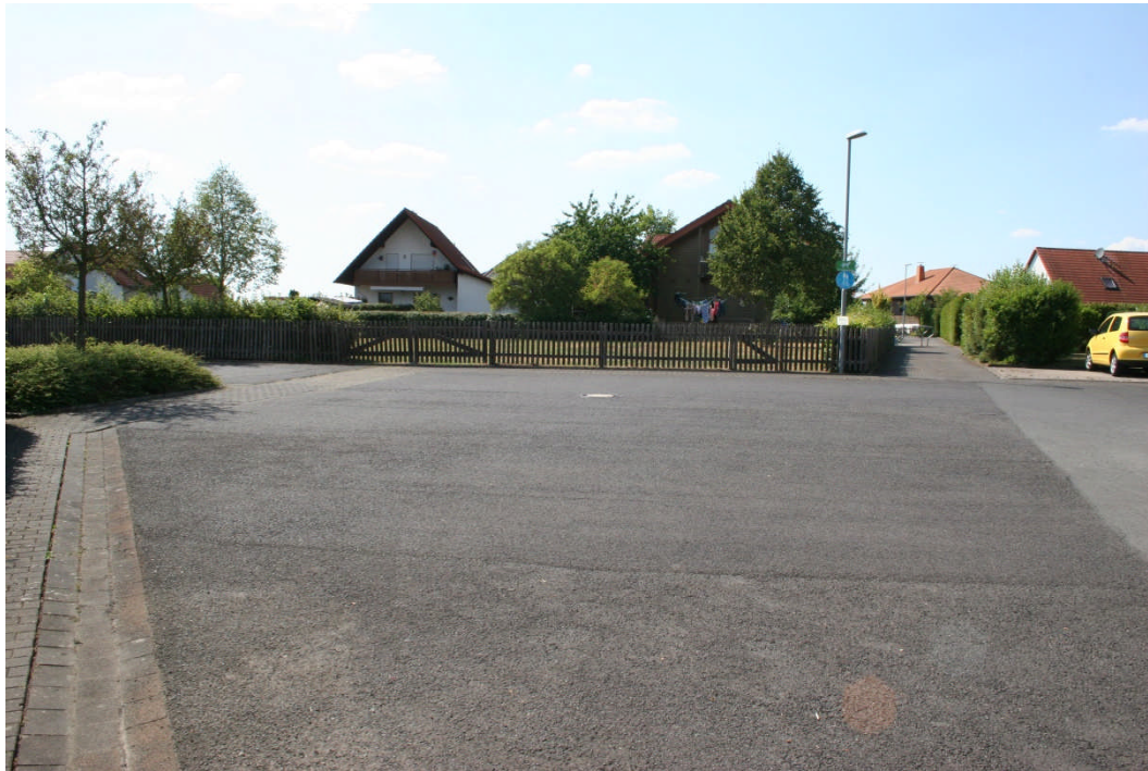
Abb. 1 Ansicht des Wendehammers vor dem ehemaligen Spielplatz „Erfurter Straße“ im Wohngebiet Wasenlängen
